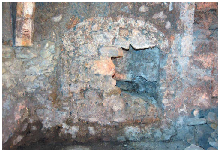
Fig. 72 : Sacristie, placard liturgique bouché dans le mur est. Cliché : L. D'Agostino
