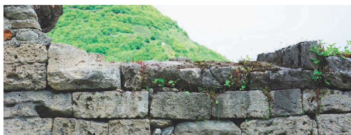
Fig. 60 : Eglise, appui d'une des baies du chœur. Cliché : E. Chauvin-Desfleurs
