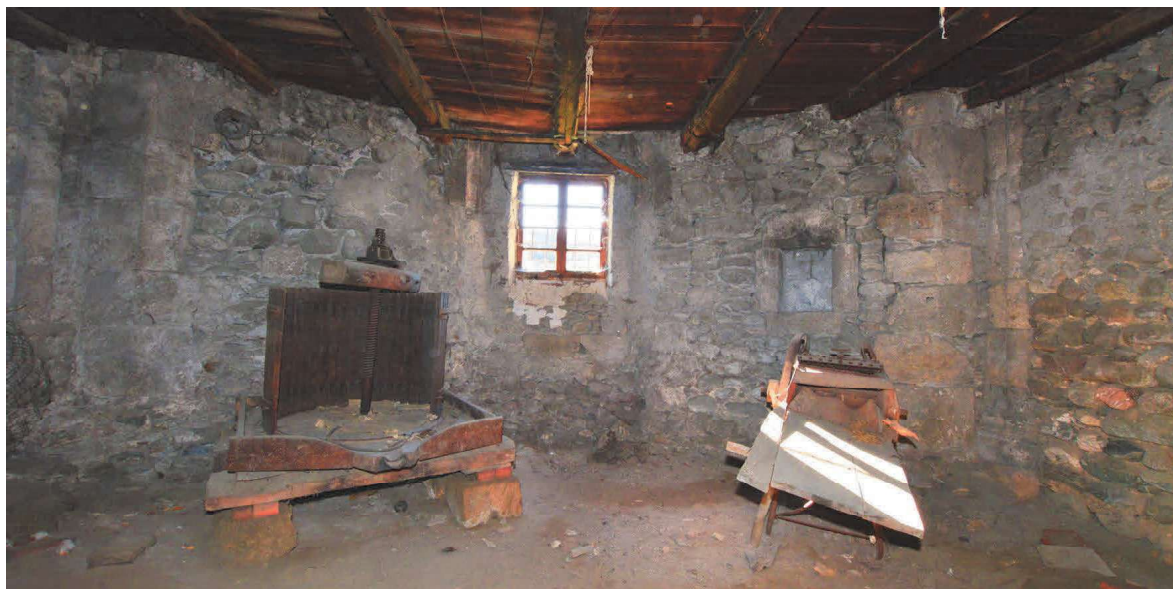
Fig. 81 : Chapelles sud-ouest, renforcement à trois pans dans le mur sud, avec placard liturgique à droite. Cliché : L. D'Agostino
