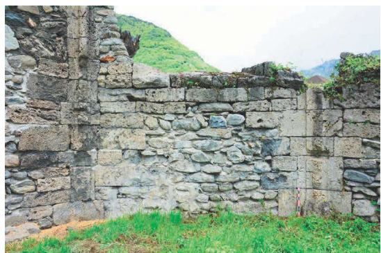
Fig. 46 : Eglise, parement interne en moellons de tuf et assises de blocs subarrondis. Cliché : E. Chauvin-Desfleurs
