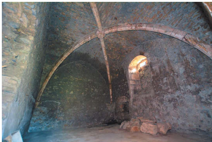
Fig. 66 : Sacristie, intérieur et voûte d'ogives. Cliché : L. D'Agostino
