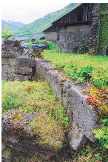
Fig. 74 : Chapelle sud-est, chemisage du chevet par le mur est de la chapelle. Cliché : E. Chauvin-Desfleurs
