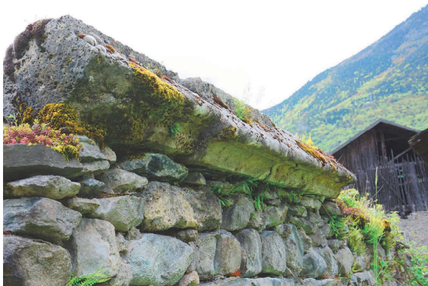
Fig. 76 : Chapelle sud-est, détail de la corniche du mur sud. Cliché : E. Chauvin-Desfleurs
