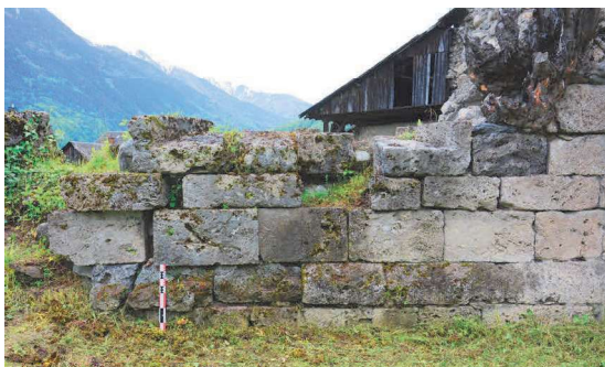
Fig. 45 : Eglise, parement externe en moellons de tuf. Cliché : E. Chauvin-Desfleurs
