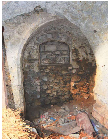
Fig. 63 : Eglise, arcature d'une porte bouchée dans le mur gouttereau nord, à l'ouest. Cliché : L. D'Agostino
