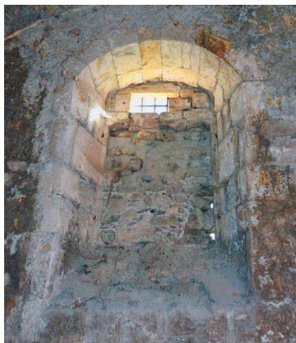
Fig. 71 : Sacristie, intérieur de la baie à meneau. Cliché : L. D'Agostino
