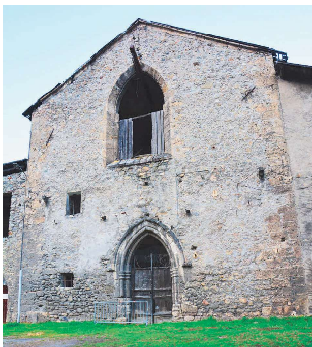
Fig. 47 : Eglise, façade ouest conservée jusqu'au faîtage. Cliché : E. Chauvin-Desfleurs
