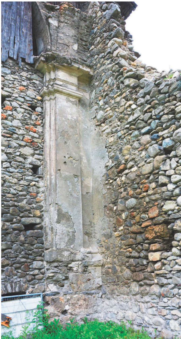
Fig. 92 : Eglise, pilastre adossé contre le mur gouttereau nord. Cliché : E. Chauvin-Desfleurs
