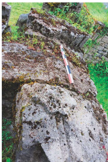
Fig. 61 : Eglise, base de meneau et rainures des vitraux d'une des baies du chœur. Cliché : E. Chauvin-Desfleurs
