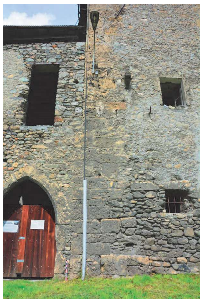
Fig. 64 : Eglise, chaînage d'angle nord-ouest. Cliché : E. Chauvin-Desfleurs
