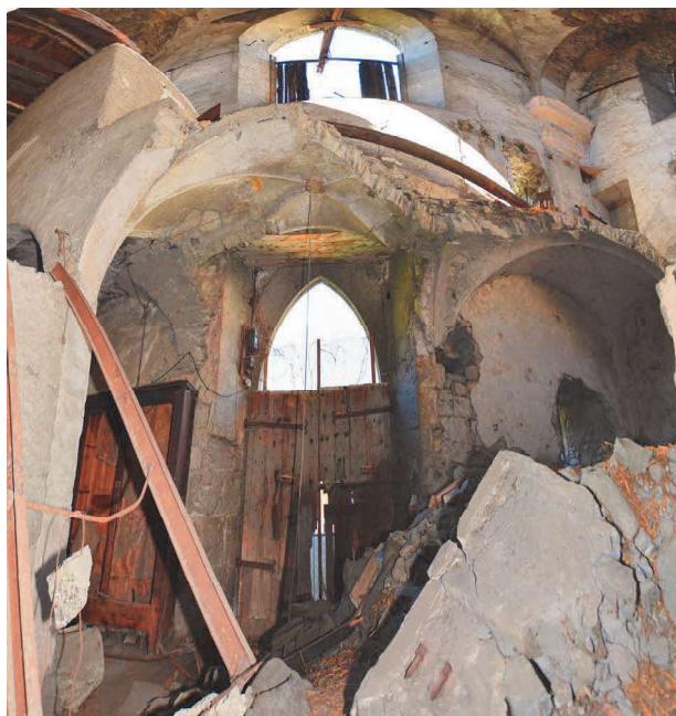
Fig. 96 : Eglise, vestiges de la tribune adossée contre la façade occidentale. Cliché : L. D'Agostino
