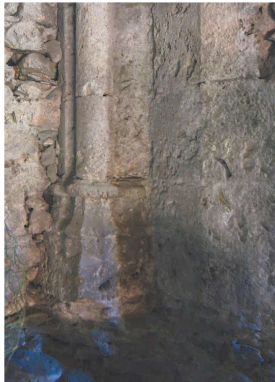
Fig. 84 : Chapelles sud-ouest, base d'un arc doubleau. Cliché : L. D'Agostino
