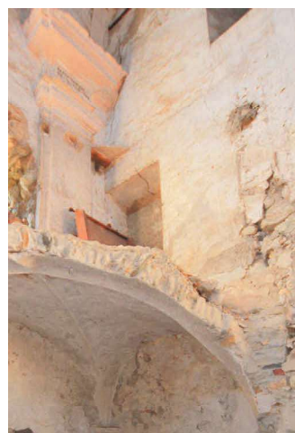
Fig. 98 : Eglise, porte bouchée située à l'étage de la tribune donnant sur l'étage du cloître au nord. Cliché : L. D'Agostino
