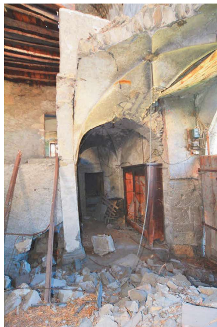
Fig. 97 : Eglise, pilier carré et voûte d'arêtes de la tribune ouest. Cliché : L. D'Agostino
