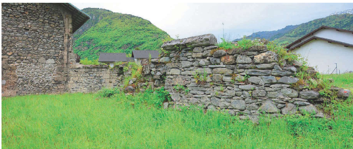
Fig. 73 : Chapelle sud-est, vestiges du mur est contre le chœur. Cliché : E. Chauvin-Desfleurs
