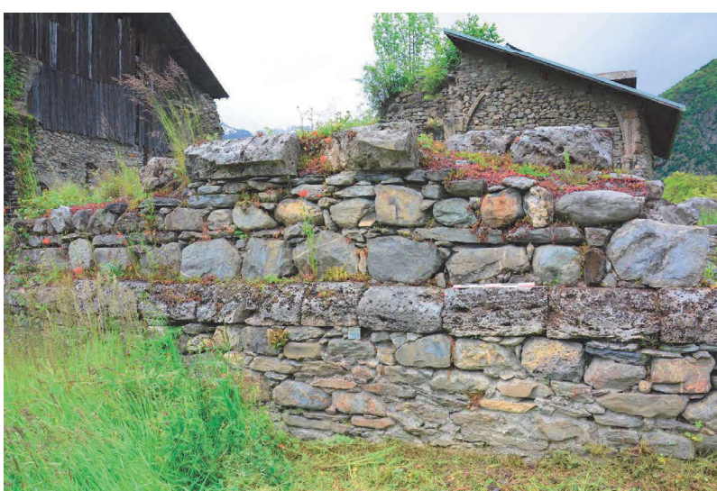
Fig. 75 : Chapelle sud-est, mur sud. Cliché : E. Chauvin-Desfleurs
