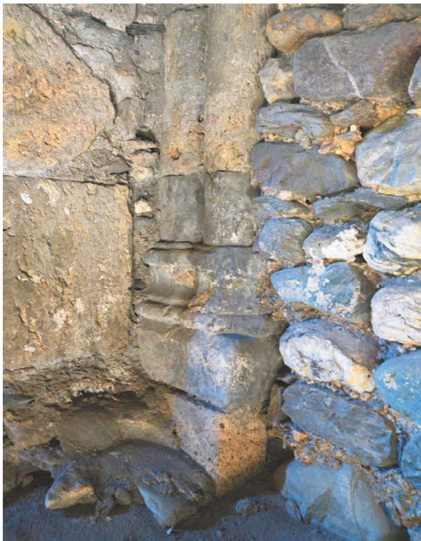
Fig. 83 : Chapelles sud-ouest, base d'un arc doubleau. Cliché : L. D'Agostino
