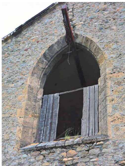
Fig. 55 : Eglise, baie axiale de la façade ouest. Cliché : E. Chauvin-Desfleurs
