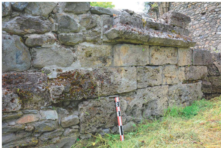
Fig. 77 : Chapelle sud-est, soubassement chanfreiné du mur oriental et base probable de contrefort. Cliché : E. Chauvin-Desfleurs
