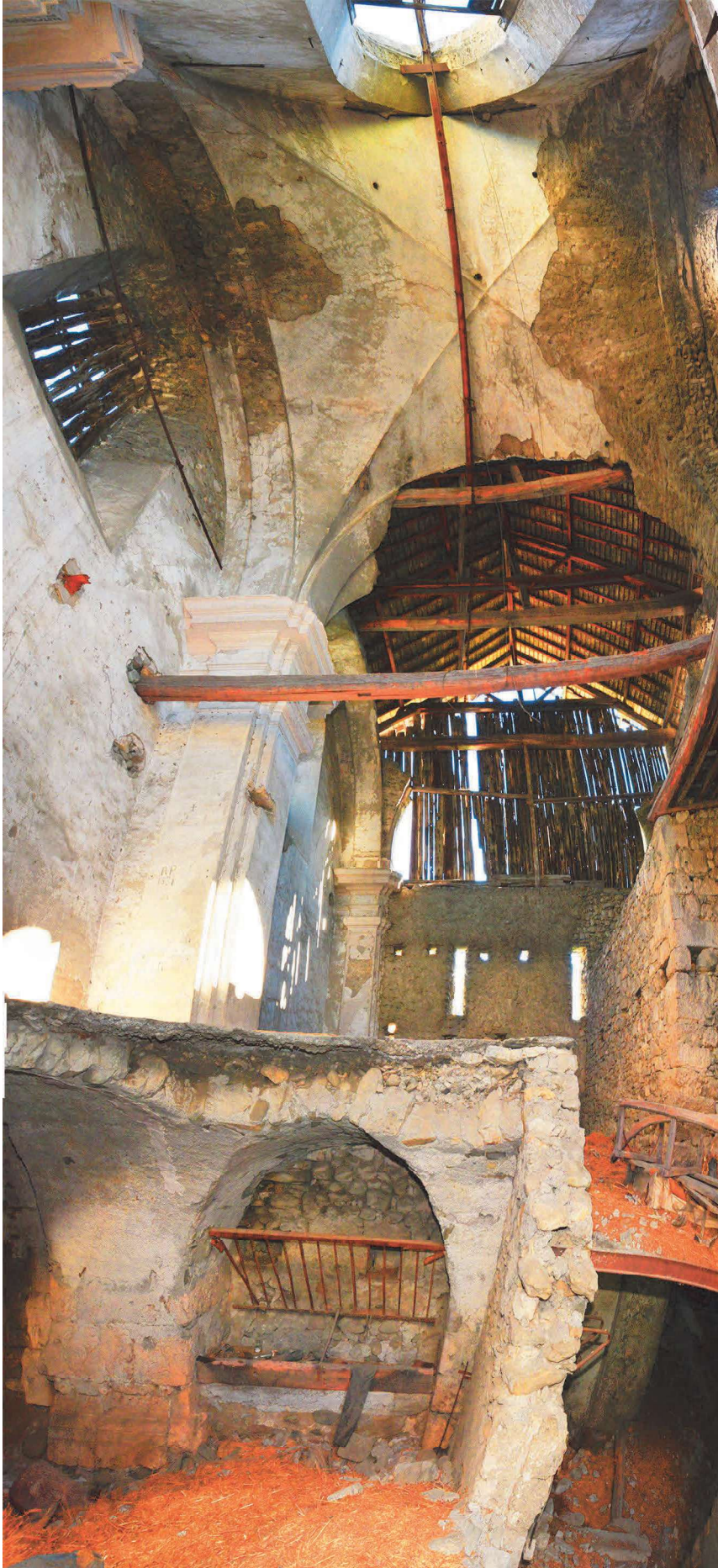
Fig. 95 : Eglise, vestiges des voûtes de la nef. Cliché : L. D'Agostino
