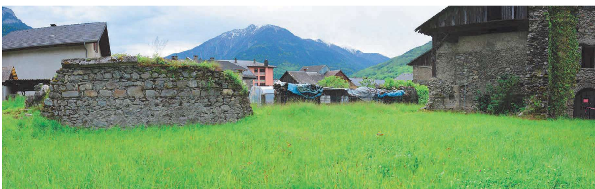
Fig. 19 : Vestiges de murs à l'emplacement de la partie sud-est de l'église. Cliché : E. Chauvin-Desfleurs
