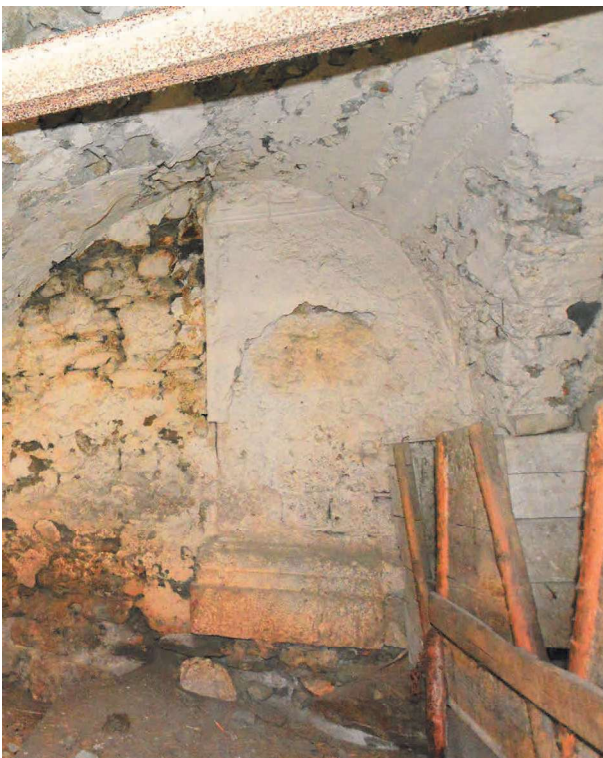
Fig. 40 : Base de pilastre de l'église, dont la fondation est apparente. Cliché : L. D'Agostino
