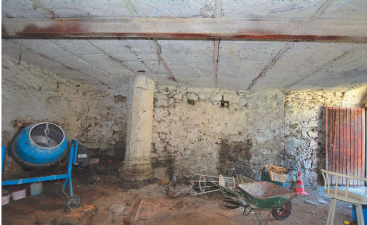
Fig. 38 : Murs de refend et dalle béton construits dans le volume de la salle capitulaire au nord. Cliché : L. D'Agostino
