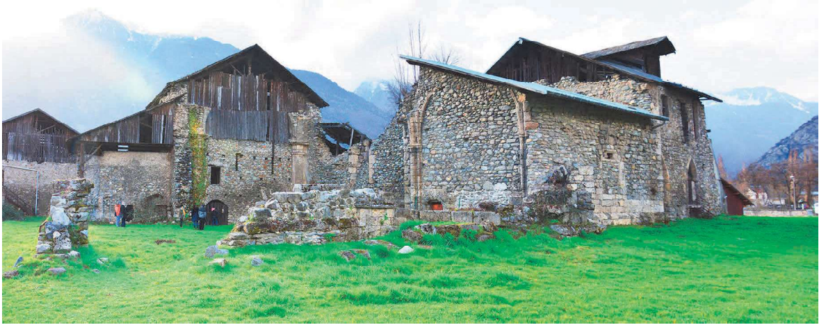
Fig. 1 : Vue générale depuis le sud-est. Cliché : L. D'Agostino
