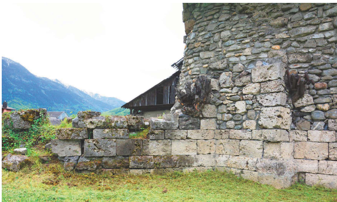
Fig. 42 : Eglise, contrefort nord-est inséré dans la construction de la sacristie. Cliché : E. Chauvin-Desfleurs
