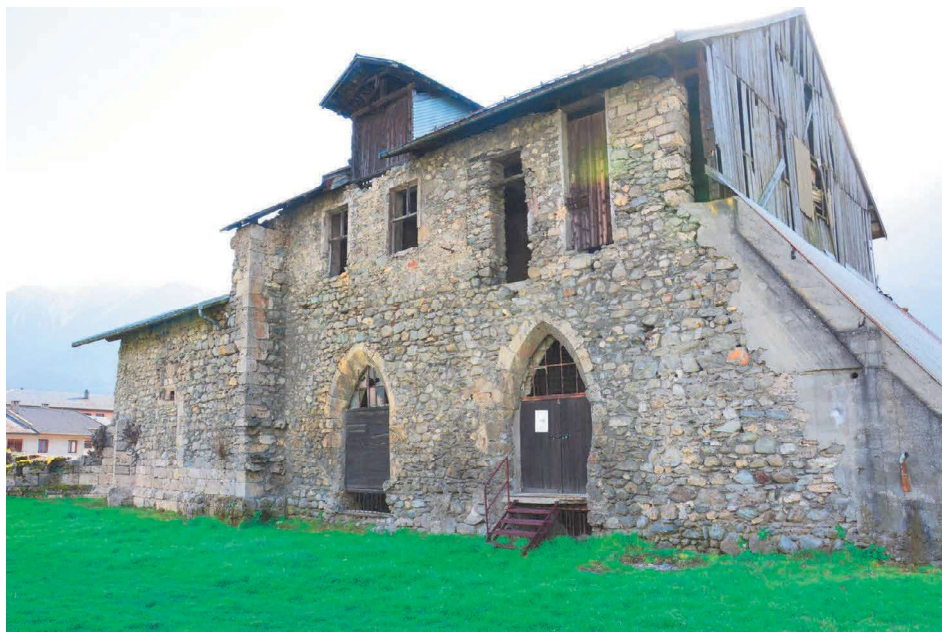
Fig. 21 : L'aile orientale du couvent, depuis le nord-est. Cliché : E. Chauvin-Desfleurs
