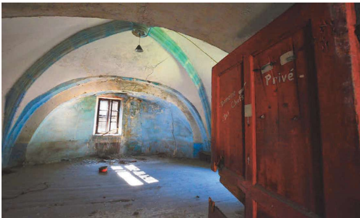
Fig. 32 : Appartement aménagé au premier étage au sud de l'église. Cliché : L. D'Agostino
