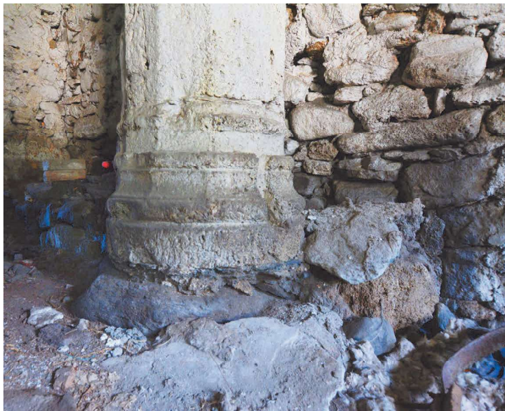
Fig. 39 : Base du pilier central de la salle capitulaire, dont la fondation est apparente. Cliché : L. D'Agostino
