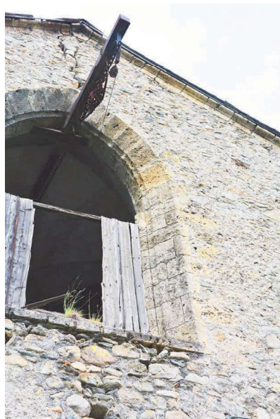
Fig. 36 : Rail de la grue agricole aménagée dans la baie axiale de la façade ouest de l'église. Cliché : E. Chauvin-Desfleurs
