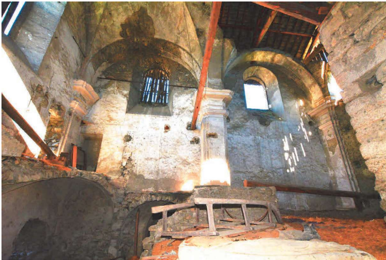
Fig. 28 : Vestiges de voûtes dans la nef de l'église. Cliché : L. D'Agostino
