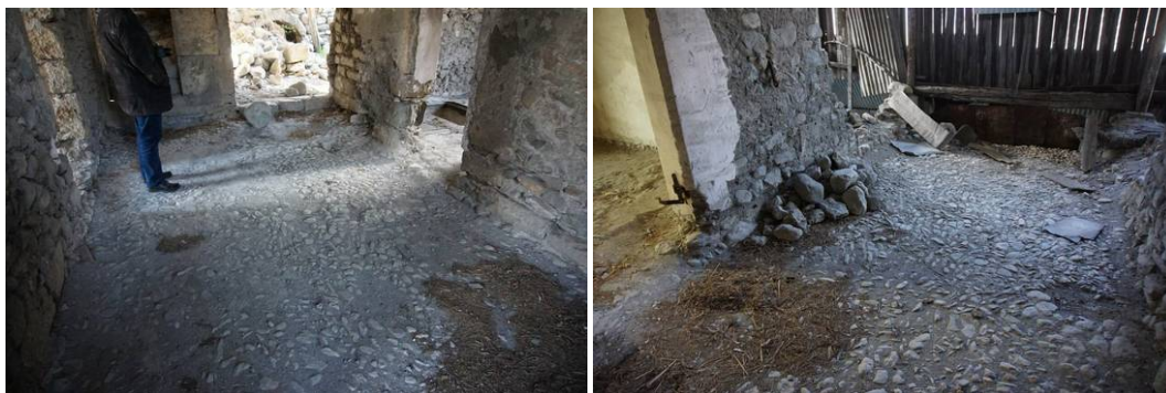
Figure 23 Salle capitulaire, niveau 2, vue sol travée centrale et des murs de refends (en appui sur les voûtes)
