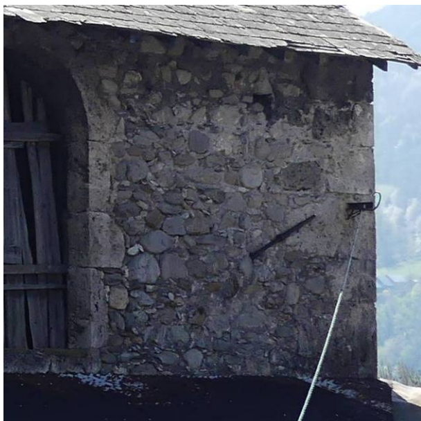
Figure 34 Église, mur gouttereau nord, ancre du tirant nord-sud
