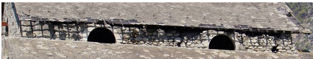
Figure 35 Église, mur gouttereau sud
