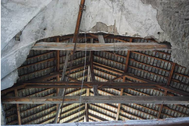
Figure 46 Église, nef, charpentes de la seconde travée vues depuis le sol de la première travée
