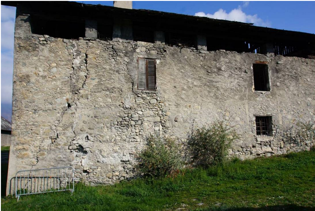
Figure 43 Église, façade sud des chapelles
