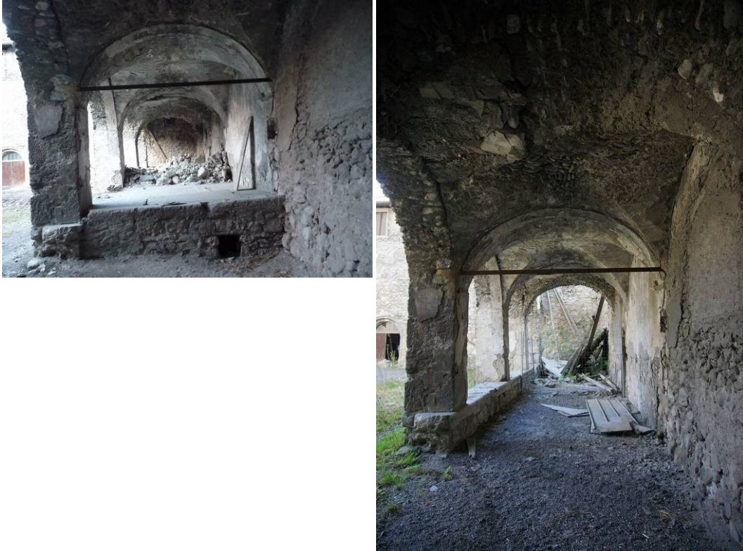
Figure 13 Cloître, aile sud, vue d'ensemble (2010 à g., 2022 à d.)
