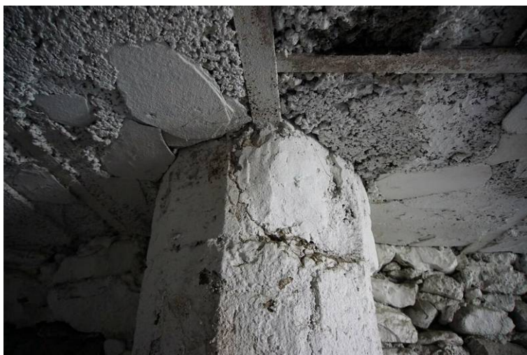
Figure 20 Salle capitulaire, travée nord-ouest, vue d'ensemble
