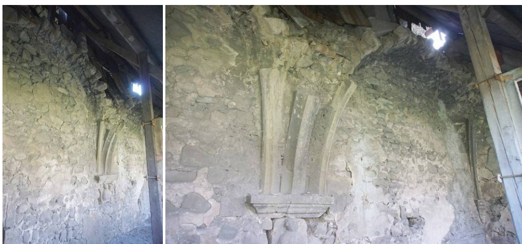
Figure 25 Salle au nord de la salle capitulaire, avec vestiges voûtes disparues
