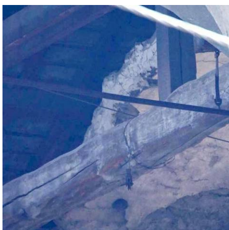
Figure 36 Église, vue du front de la voûte (photo prise de l'extérieur à travers la fenêtre, zone non visible depuis une zone sécurisée actuellement)
