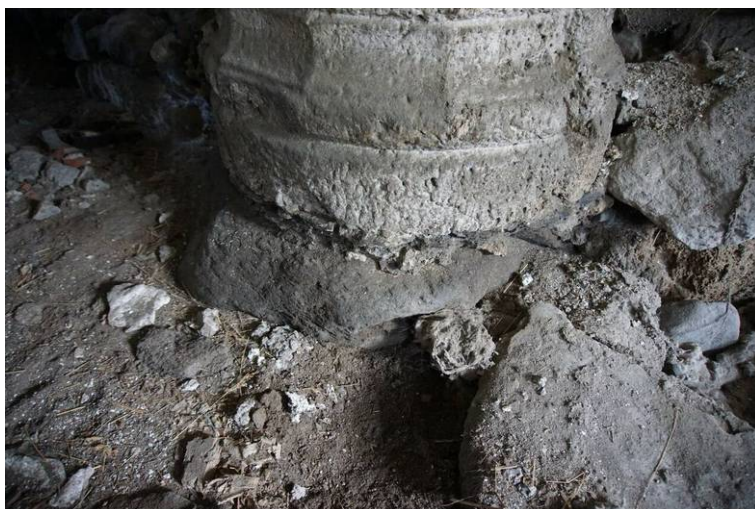
Figure 24 Salle capitulaire, détail du pied de la colonne
