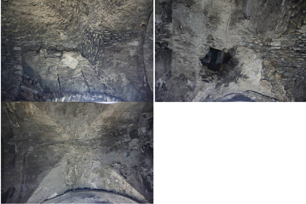
Figure 15 Cloître, aile sud, vue de l'intrados
