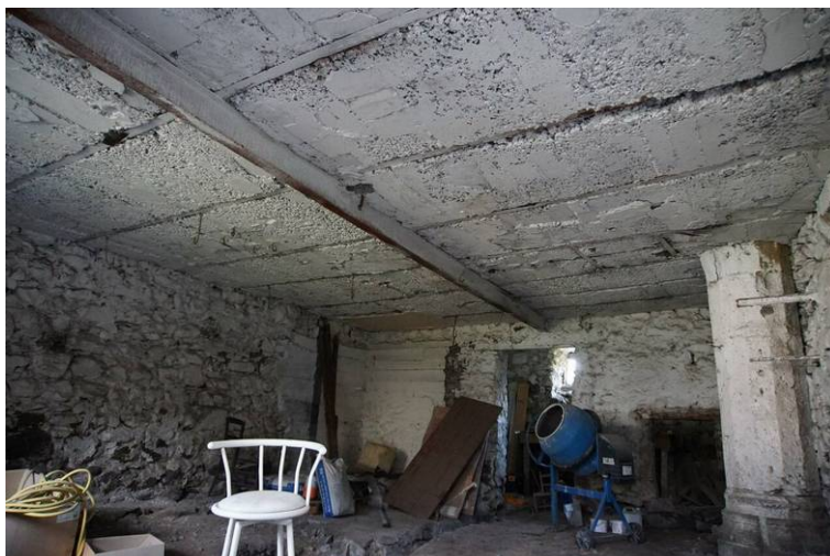
Figure 21 Salle capitulaire, travée nord-ouest, vue d'ensemble niveau 0
