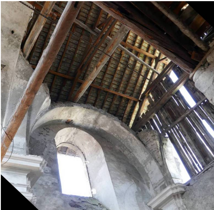
Figure 47 Église, nef, charpentes de la seconde travée vues depuis le sol de la première travée
