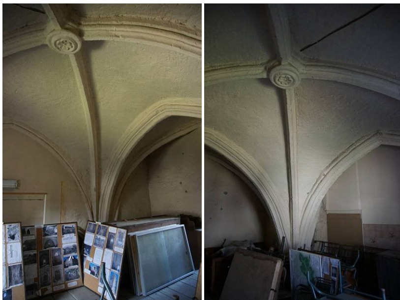
Figure 19 Salle capitulaire, travée nord-ouest, vue d'ensemble
