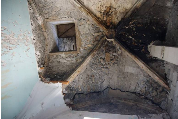
Figure 26 Salle capitulaire, travée sud-ouest
