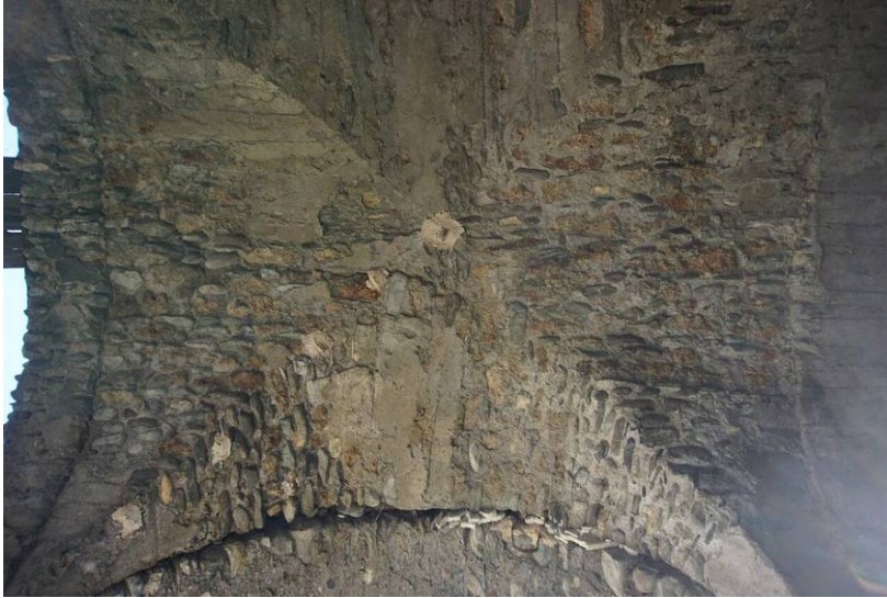
Figure 9 Vue de dessous d'une travée de l'aile ouest
