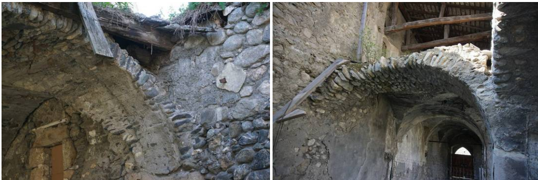
Figure 10 Cloître, vue de la composition des voûtes (aile ouest à g., aile sud à d.)
