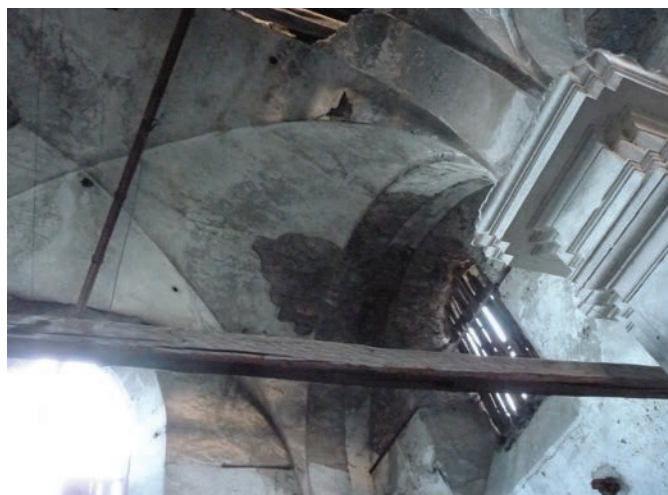
ph90) voûte église 2010 (D. Perron)
