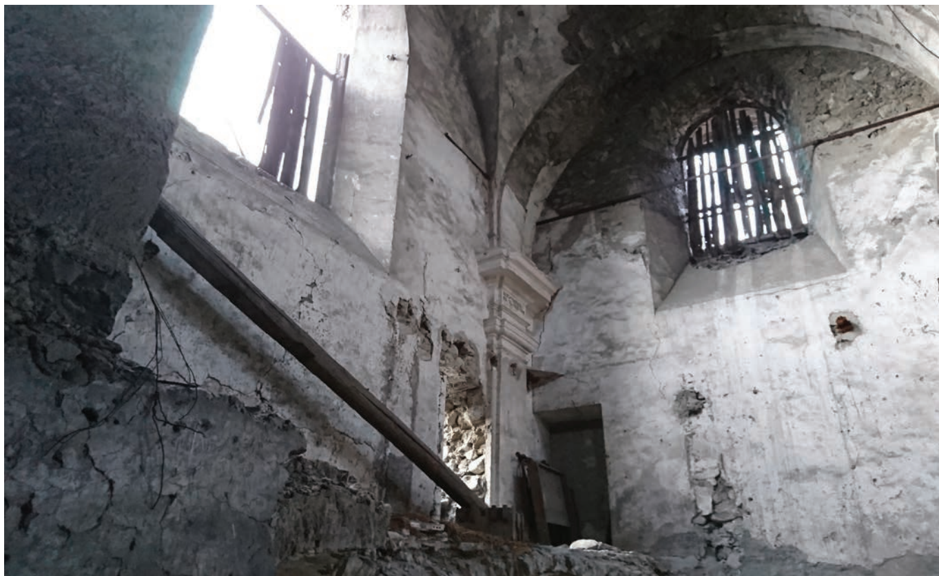
Ph88) voûtes au dessus de la tribune de l'église 2016 (D. Perron)
