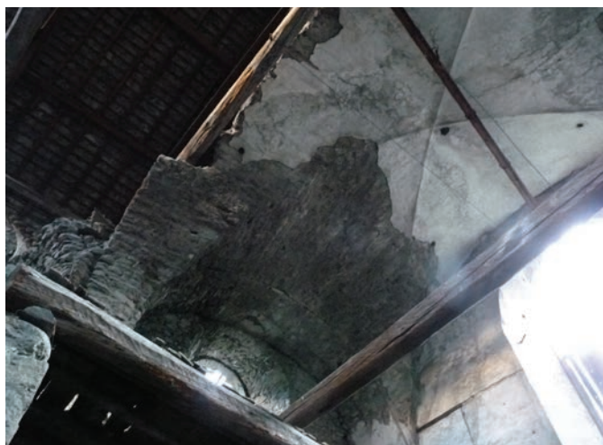
ph89) voûte église 2010 (D. Perron)
