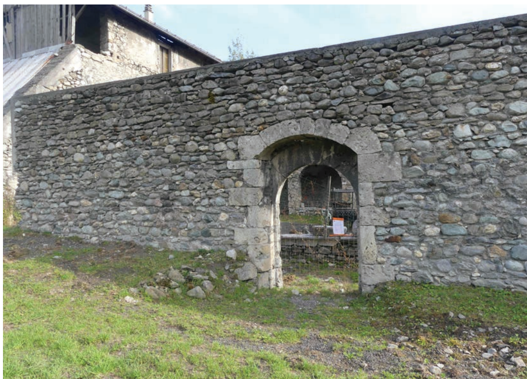
Ph10) Mur Nord façade Nord 2019 (D. Perron)
